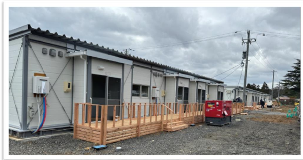
能登町鶴川地区応急仮設住宅建設現場(2/23撮影)
