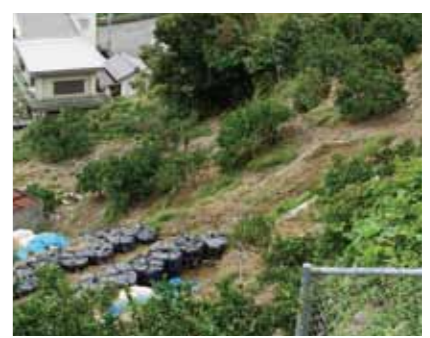
▲7月の大雨で果樹園の地盤が崩れた場所。下の住宅に被害が及ばないように応急処置の土のうが積まれています
