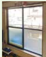
断熱内窓 LIXIL インプラス コープハウジング担当: 柳沼
